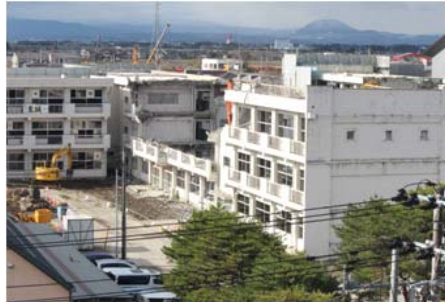
〈11/11 中央校舎解体〉
